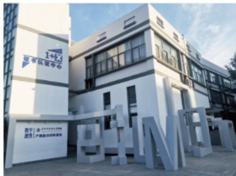
BIM 实训室外貌
