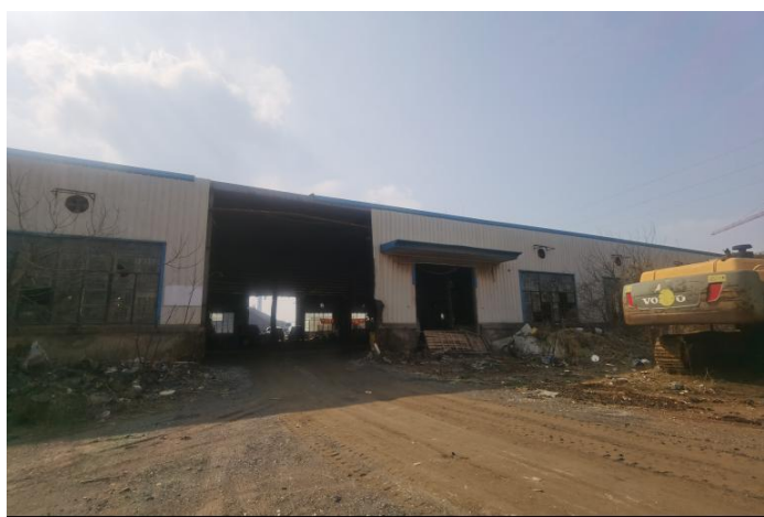
混凝土搅拌站
