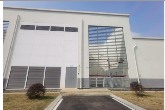
预留 2 号主变室（左）及散热器室（右）
