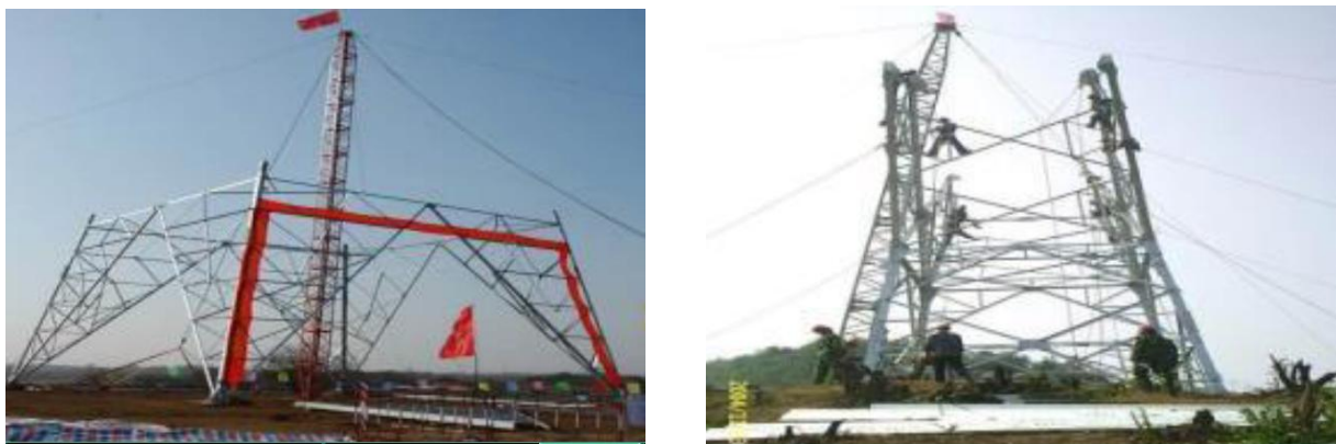
图 1-1 类似线路工程铁塔组装现场图
