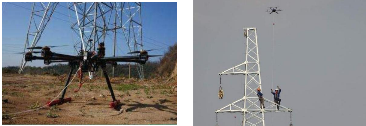
图 1-2 类似线路工程无人机展架线现场图
