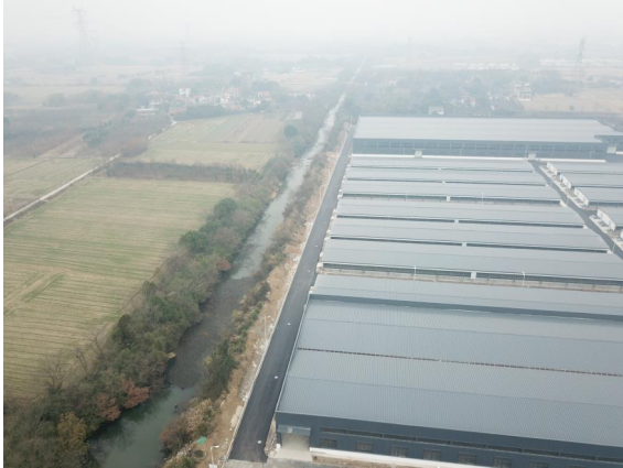
项目区西侧双机埠港现状
