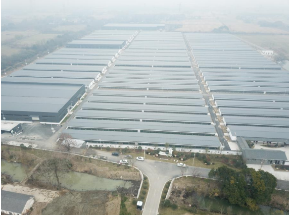
项目区建构筑物现状
