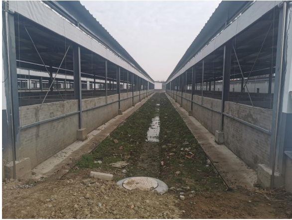
沿路雨水管道现状
