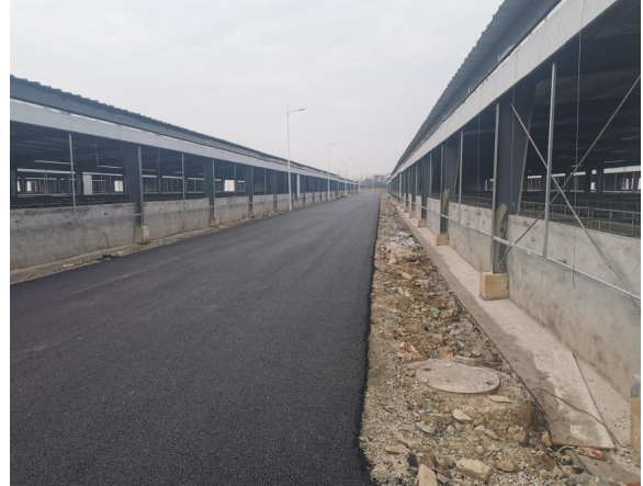
沿路雨水管道现状
