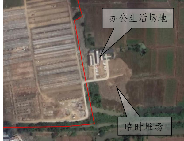
一期工程东侧办公场地
