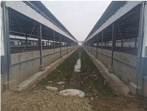
项目区羊舍之间排水沟现状
