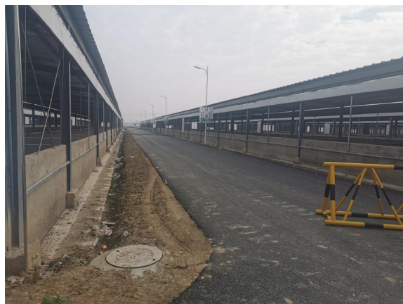
图 2-3 项目区内道路现状
