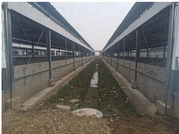
图 2-4 项目区羊舍之间排水沟现状
