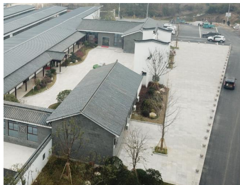
图 2-13 展示区域门前硬地铺装
