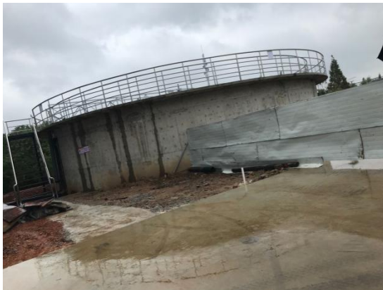
照片 3 项目区已建成污泥浓缩池
